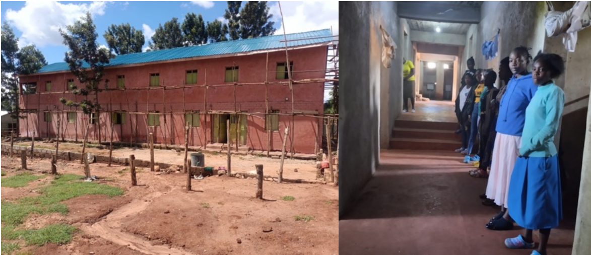
Die fast fertigen neuen Dorms im Februar 2024
