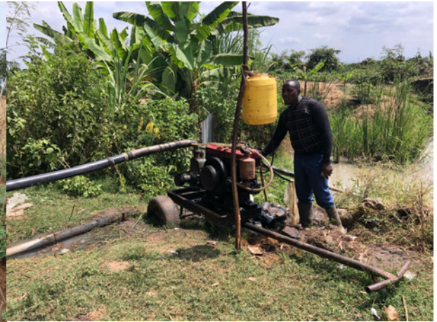
Generator für die Bewässerung
